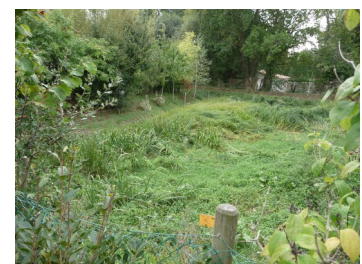
Bassin de rétention zone urbaine pavillonnaire
